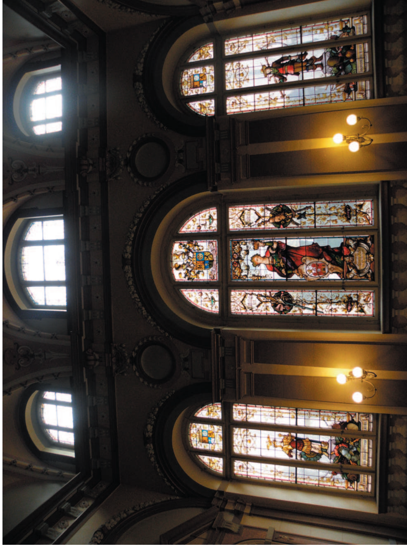
Vitraje oken II. mezipatra. Plochy vitrají jsou kompletní nepoškozené ale olověná vazba je původní a při přemístění vitrají do nových rámu bude nutné vitraje přeložit do nového olova.
