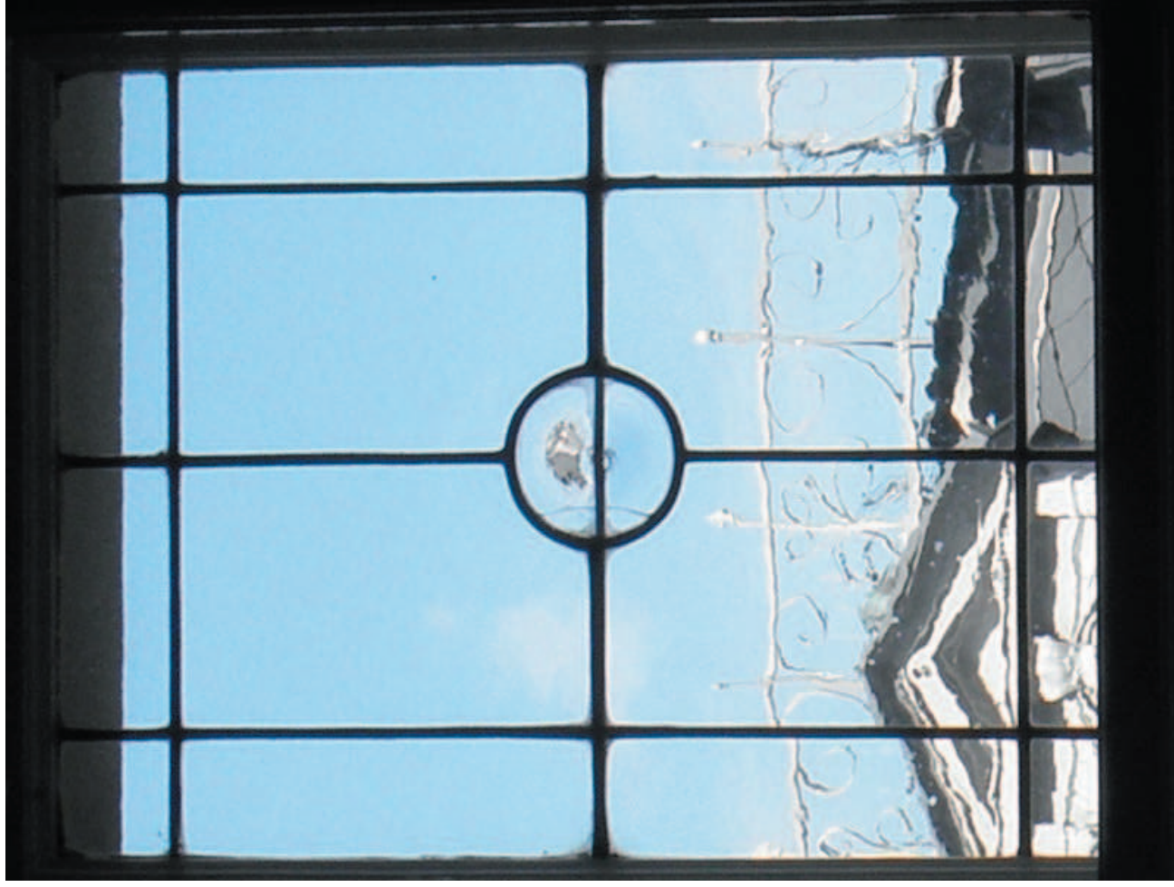
V kanceláři č. 207 jsou dvě čtyřkřídlá okna. V horní polovině jsou opět vitrajové výplně. Vrchní výplně jsou složené z bucen s červenou a čirou bordurou . Výplně pod nimi jsou opět se středovou bucnou jako u stejného typu čtyřkřídlých oken.
