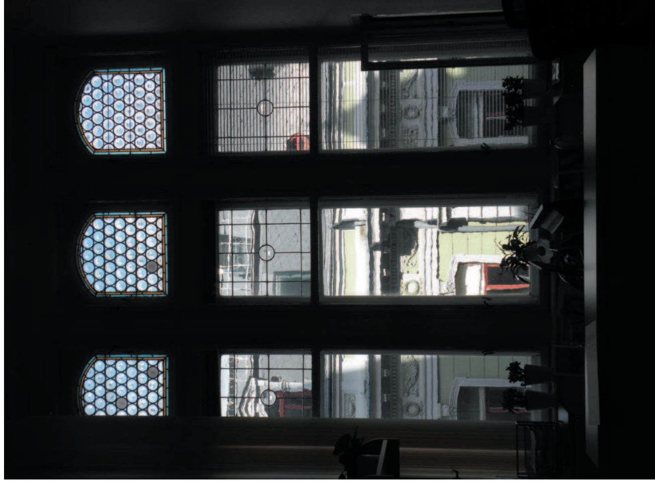
Kancelář s číslem místnosti 205. Zde je trojdílné okno. V horní části okna je opět šest vitrajových výplní stejného typu. U výplní s bucnamí je tentokrát bordura žlutá a čirá. Do plochy výplně bude nutné přeložit do nové olověné vazby.
