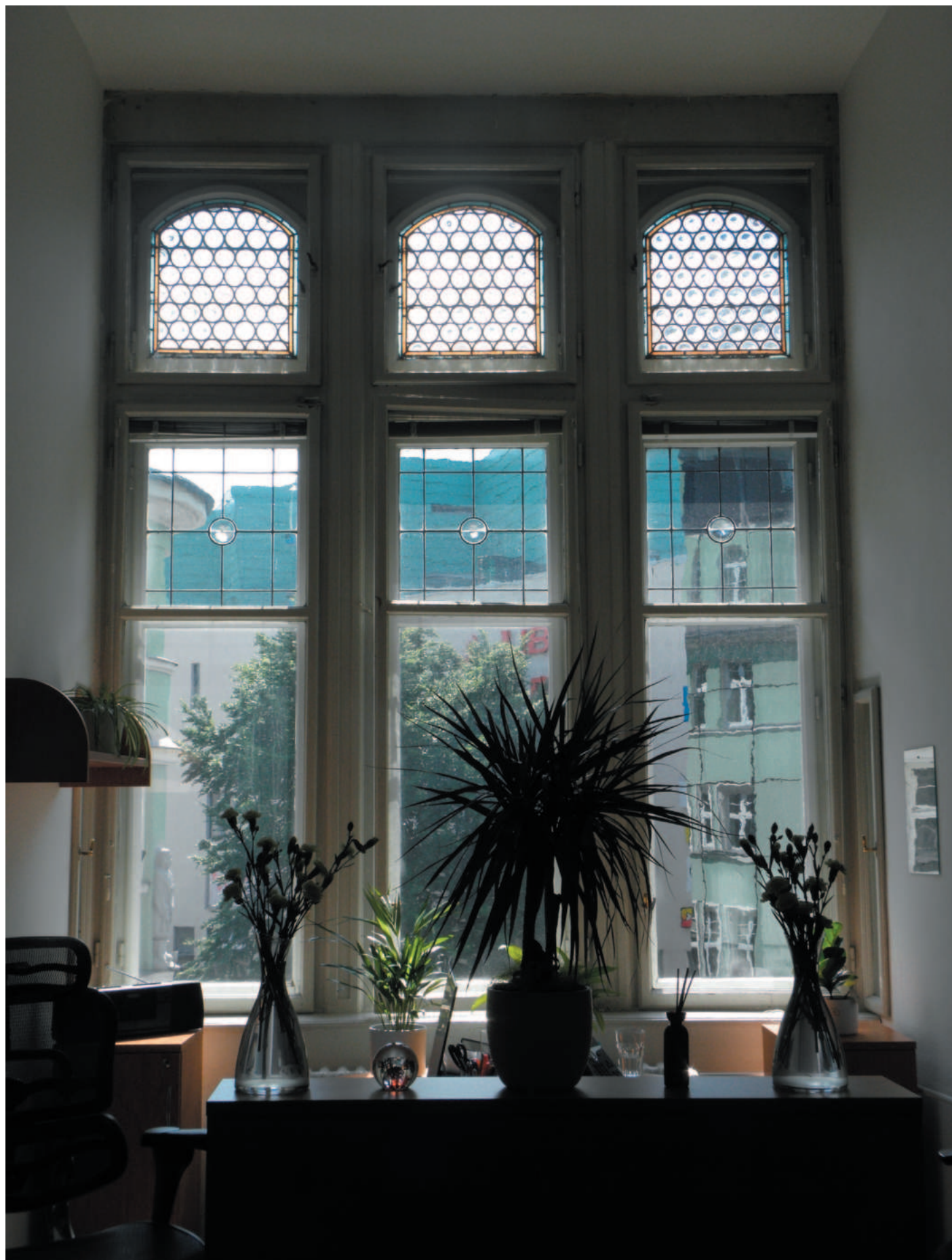
Sekretariát náměstka primátora. Místnost č. 214. Zde je jedno trojdílné okno se stejným typem vitrají. Výplně složené z bucen mají v borduře použitá žlutá a čirá skla.
