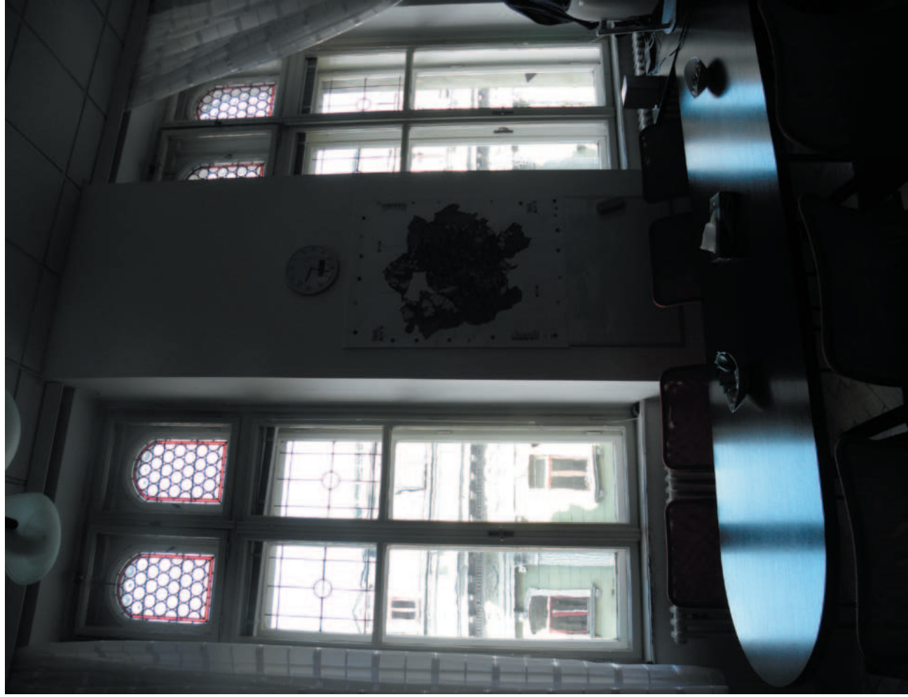
V kanceláři č. 207 jsou dvě čtyřkřídlá okna. V horní polovině jsou opět vitrajové výplně. Vrchní výplně jsou složené z bucen s červenou a čirou bordurou . Výplně pod nimi jsou opět se středovou bucnou jako u stejného typu čtyřkřídlých oken.
