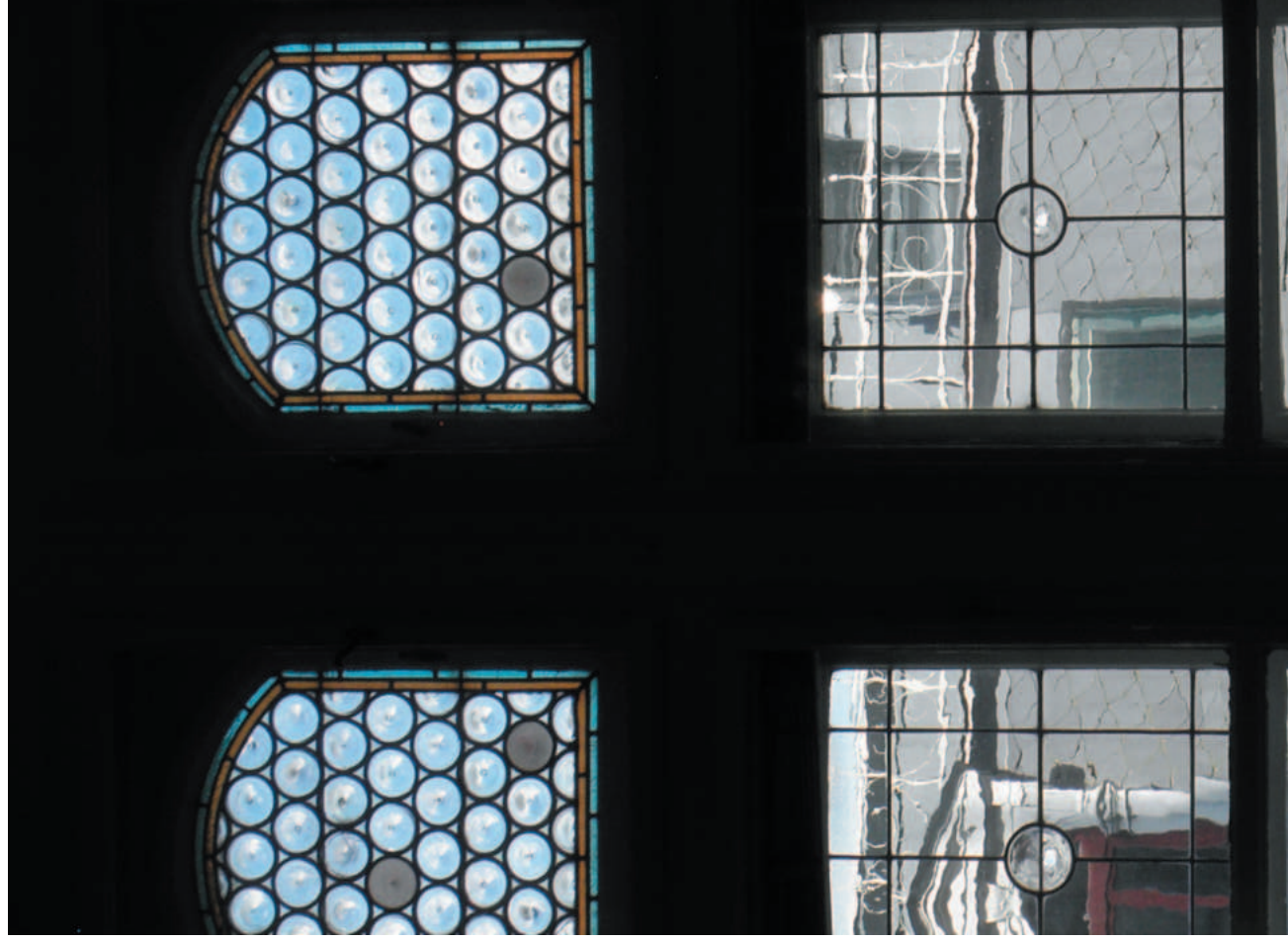
Kancelář s číslem místnosti 205. Zde je trojdílné okno. V horní části okna je opět šest vitrajových výplní stejného typu. U výplní s bucnamí je tentokrát bordura žlutá a čirá. Do plochy výplně bude nutné přeložit do nové olověné vazby.
