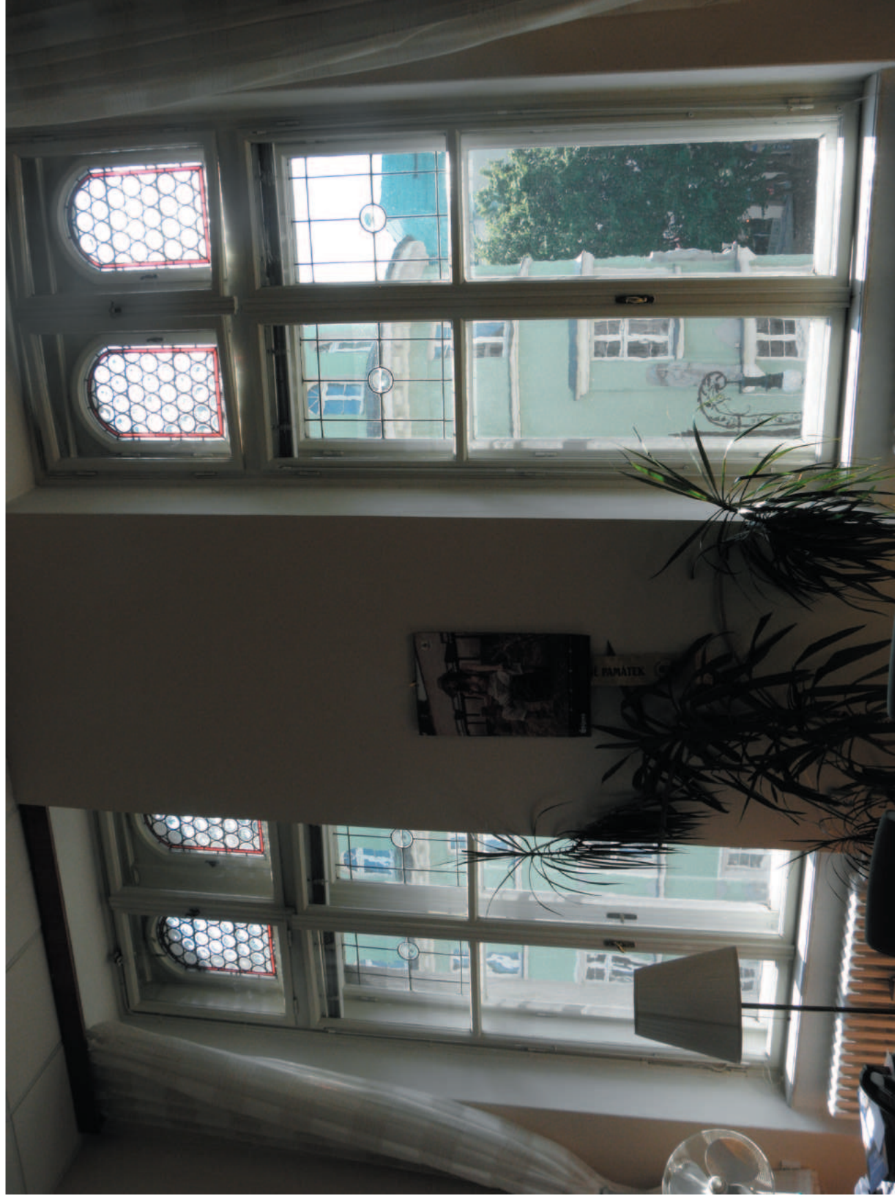
Kancelář náměstka primátora. Místnost č. 215. Zde jsou dvě čtyřkřídlá okna se stejným typem vitrají v horní polovině. Výplně skládané z bucen mají v borduře použitá červená a čírá skla.
