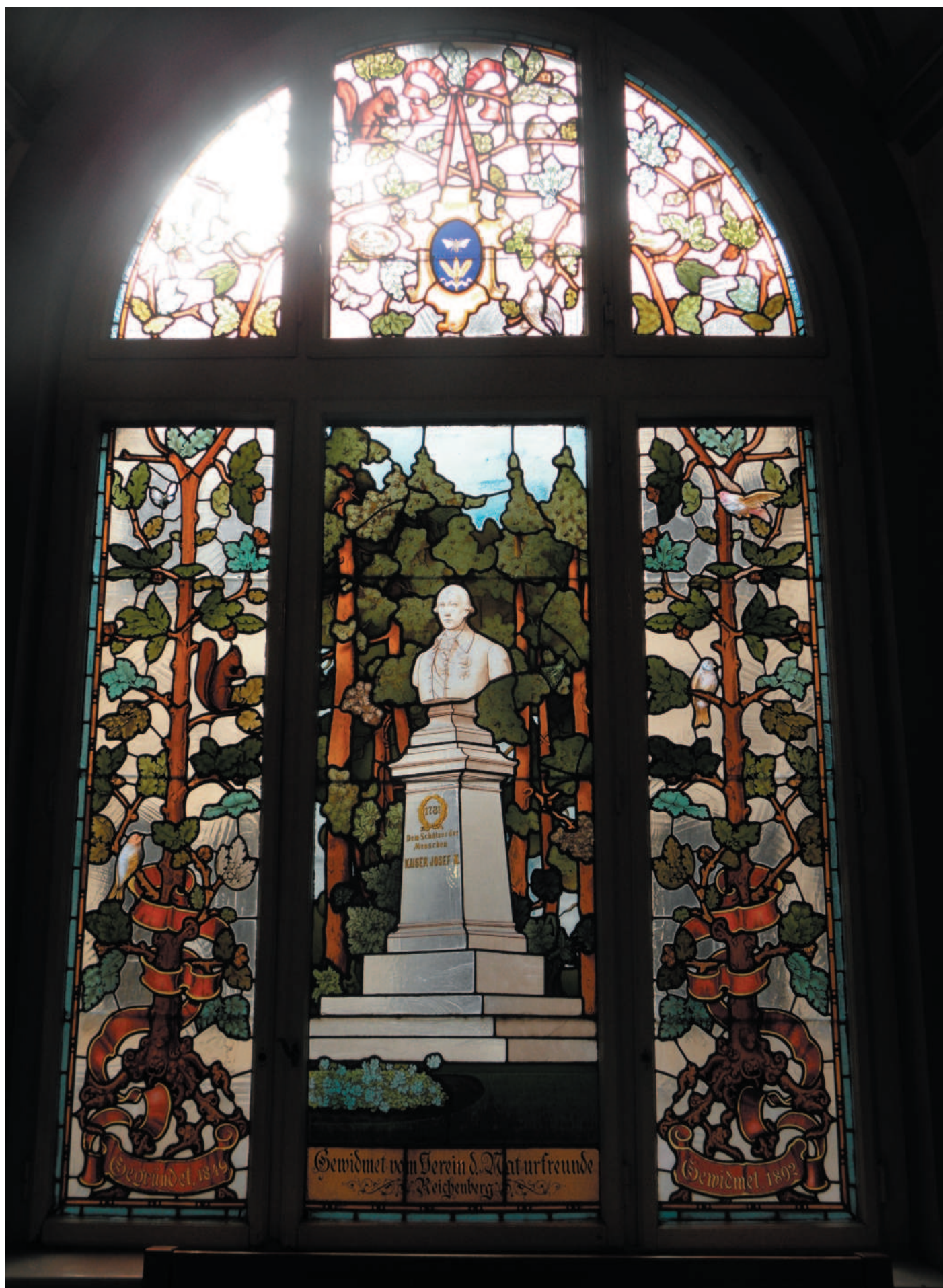
Malovaná vitraj levé chodby umístěná směrem do atria radnice. Plocha vitraje je nepoškozená. Olovo na větší části plochy je původní. Střední spodní výplň byla v dávné minulosti zřejmě přeložena a opravena. Je vidět, že do ní bylo zasahováno. Při přemístění vitraje do nových rámců bude vitraj přeložena do nové olověné vazby.
