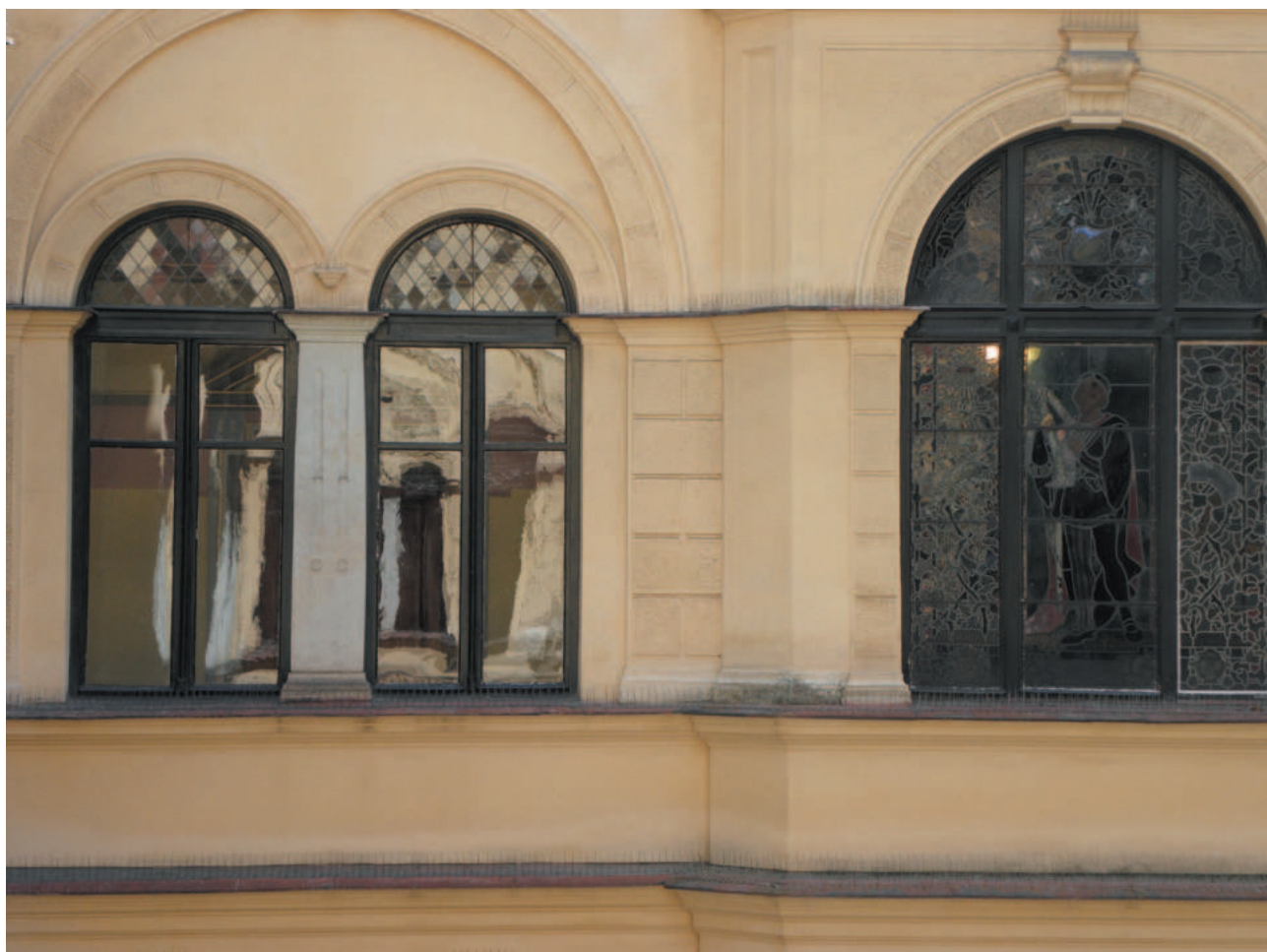
Okna v pravé chodbě směrem do atria radnice s vitrajovými výplněmi složenými z kosočtverců v horní obloukové části. Výplně jsou uvolněné. Při přemístění do nových oken se musí přeložit do nové olověné vazby.
