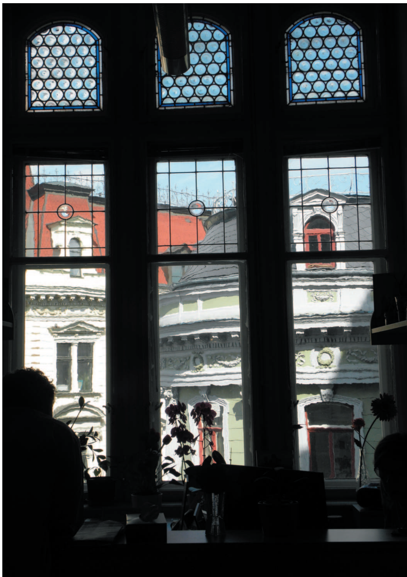
V kanceláři č. 208 je opět trojdílné okno. Je zde opět šest horních výplní složených do olova. Jsou to stejné typy vitrají. Bucnové výplně mají borduru z modrého a čirého skla. Některé bucny jsou prasklé.
