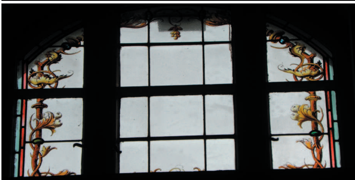
Vitraje horních oken mezipatra s malovaným rostlinným dekorem. Plochy vitrají jsou neporušené, olovo opět původní. Na plochách výplní je letitý nános nečistot. Při přemístění vitrají do nových rámu budou vitraje přeloženy do nové olověné vazby.
