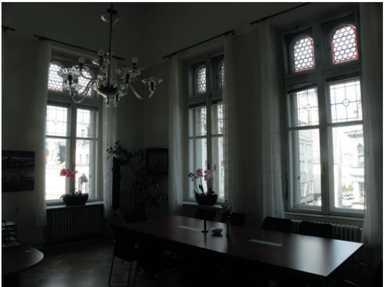
Do místnosti 208 B je vchod z kanceláře č.208. V této místnosti jsou čtyři čtyř křídlová okna se stejným typem vitrají. Výplně složené z bucen mají červenou a čirou borduru. Všechny vitrajové výplně těchto typů jsou dožilé a musejí se přeložit do nové olověné vazby.
