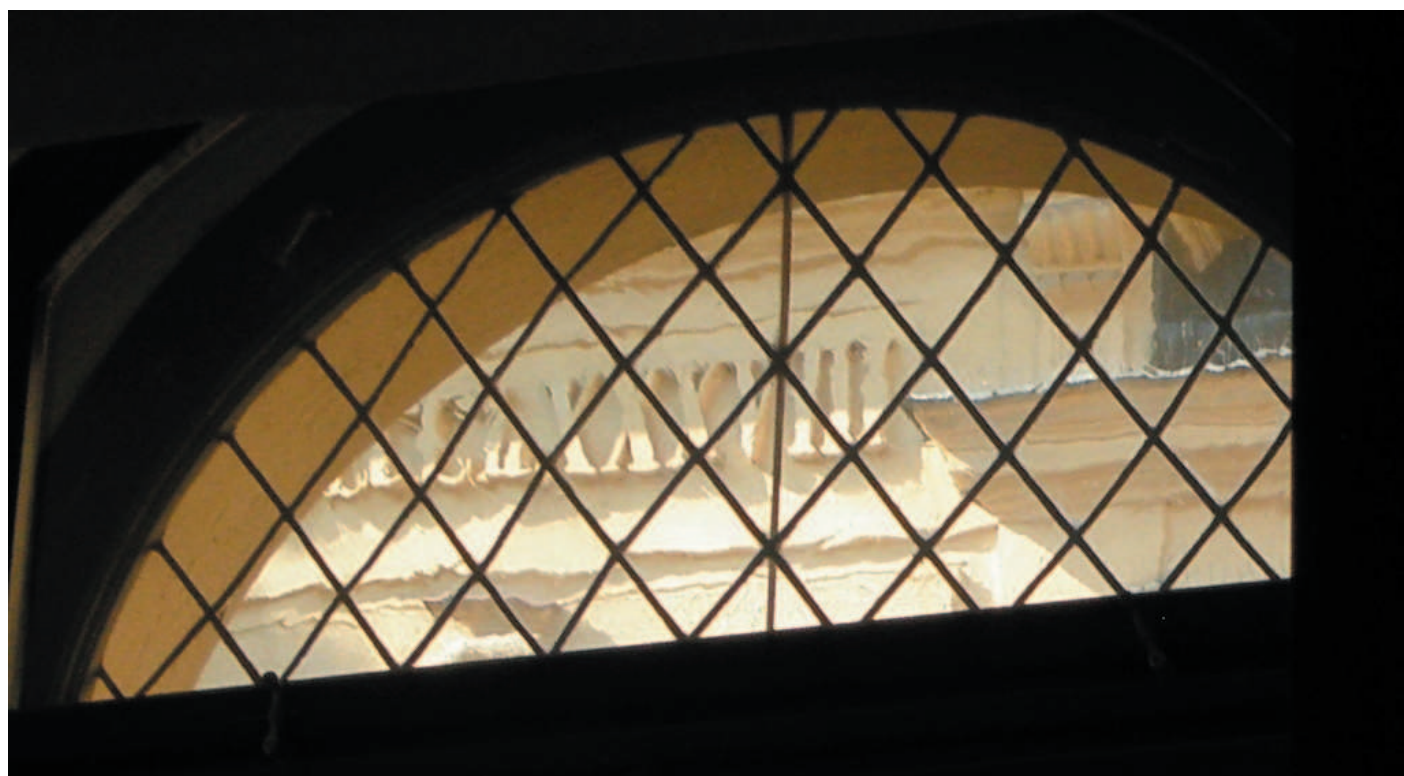
Okna WC u salonku předsálí Obřadní síně. Na detailu výplně je vidět jak je vrchní oblouková výplň oken skládaná z kosočtverců v ploše zprohýbaná.
