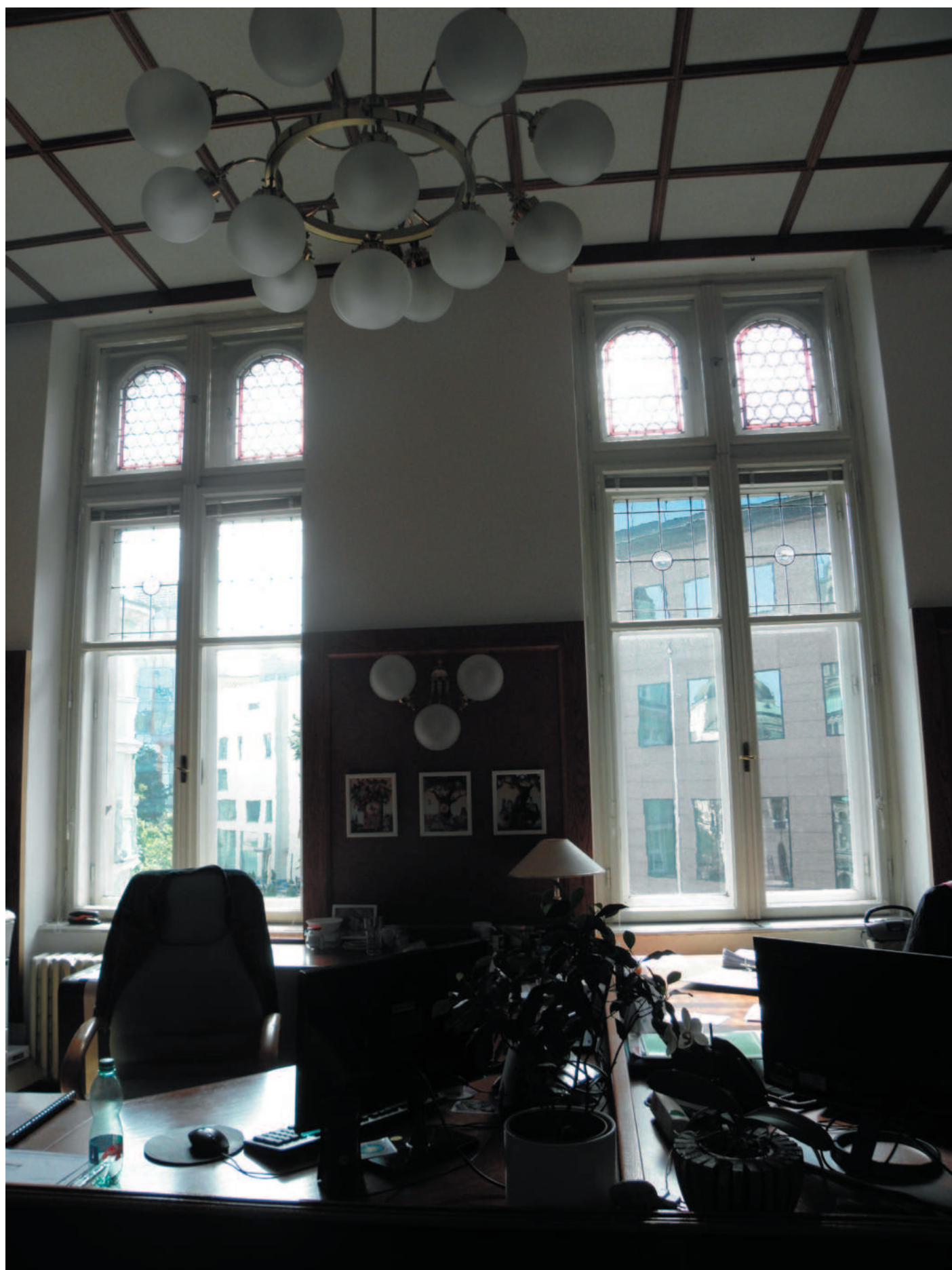
Místnost sekretariátu primátora č. 212. Zde jsou dvě čtyřkřídlá špaletová okna stejného typů a se stejnými vitrajemi. Výplně složené z bucen mají červené a čiré sklo v borduře.
