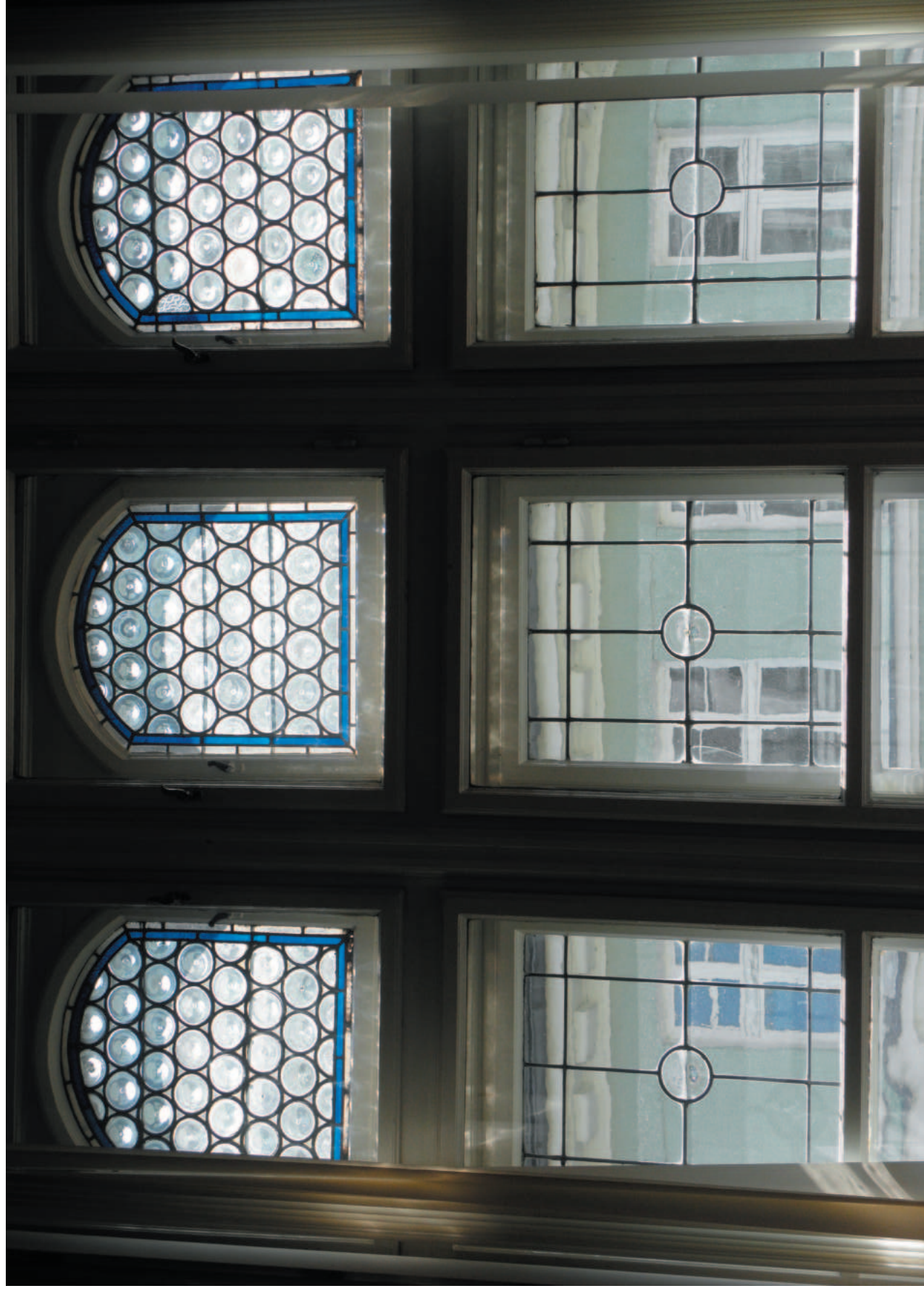
Místnost před kanceláří primátora. V místnosti je jedno trojdílné okno s šesti vitrajovými výplněmi stejného typu. Výplně s bucnami mají borduru z modrého a čírého skla.
