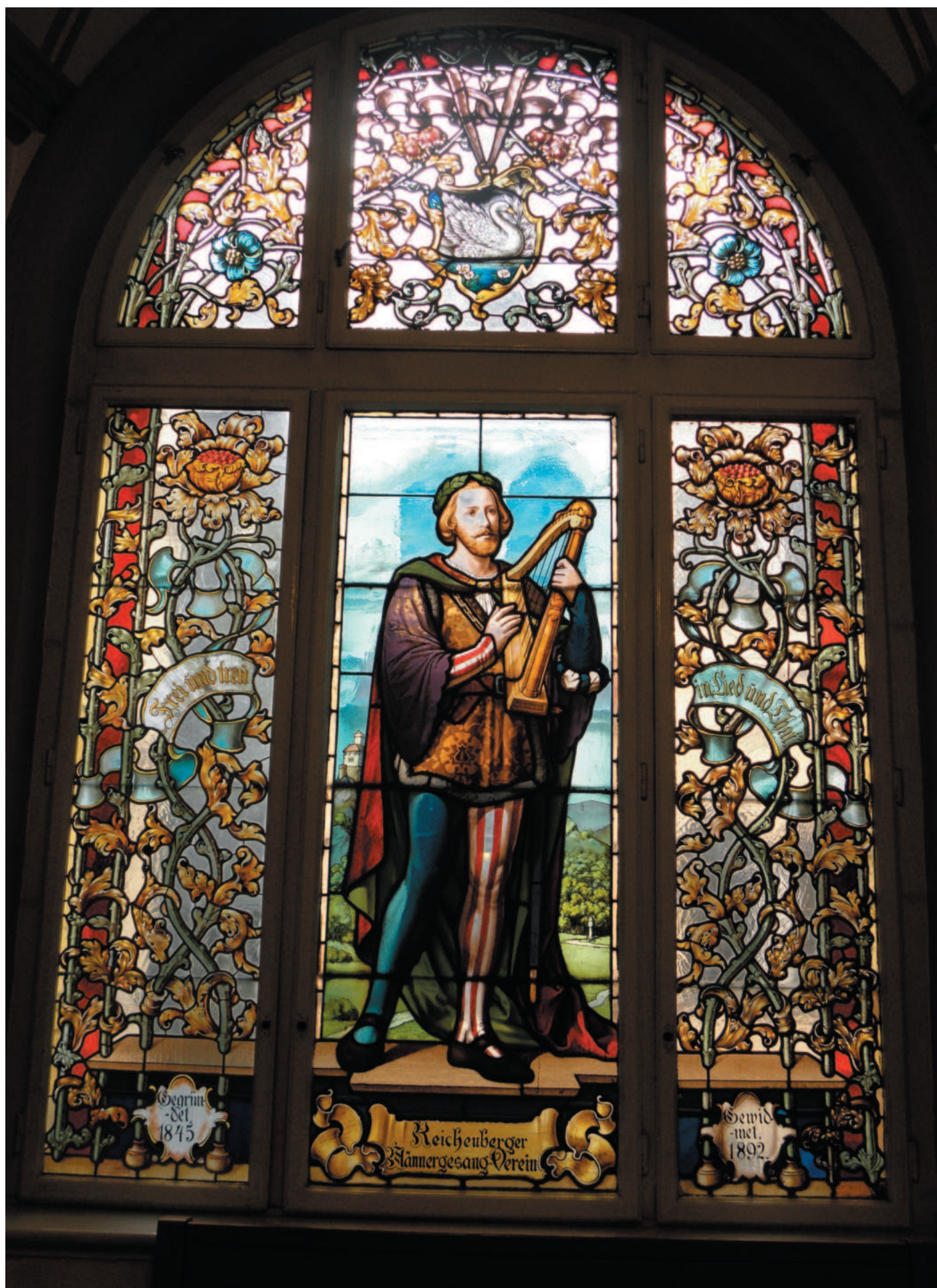
Malovaná vitraj pravé chodby umístěná směrem do atria radnice. Plocha vitraje je nepoškozená. Levá výplň byla v nedávné době zrestaurovaná. Olovo na další části plochy je původní. Při přemístění vitraje do nových rámců budou zbývající výplně přeloženy do nové olověné vazby.
