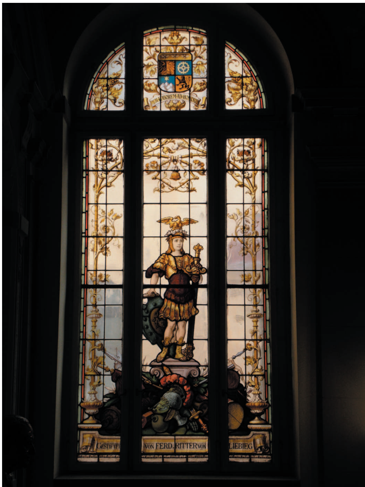
Spodní vitraj levého okna mezipatra. Je zde opět vidět vynikající výtvarná a řemeslná práce. Vitraj je v ploše neporušená, olověná vazba původní. Sponzoroval ji Franz Rittner z Liebiegu. Při přemístění vitraje do nových rámců bude vitraj přeložena do nové olověné vazby.
