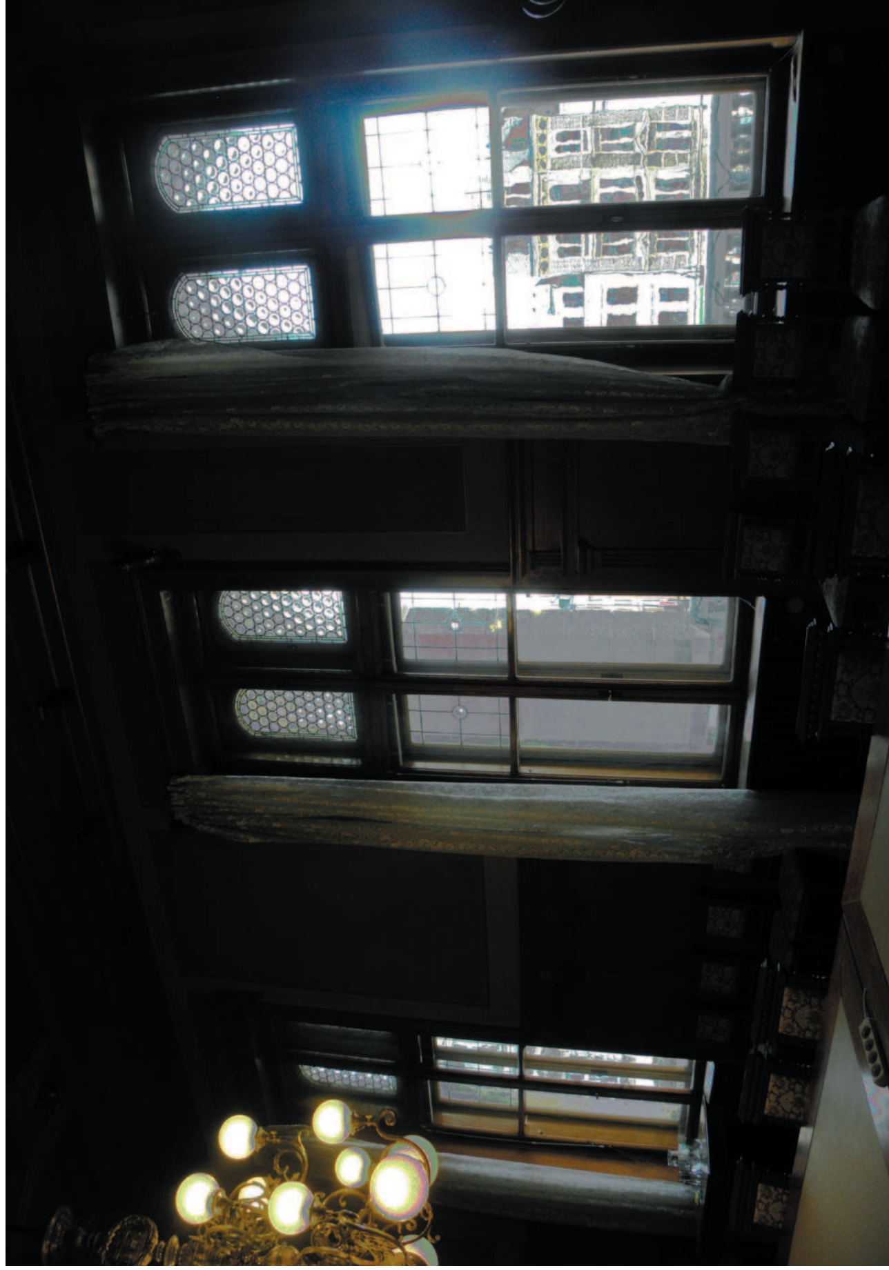
Zasedací místnost č. 210. Zde jsou tři typizovaná čtyřkřídlá špaletová okna v horní polovině s vitrajovými výplněmi stejného typu. Výplně složené z bucen mají borduru ze zeleného a čírého skla.
