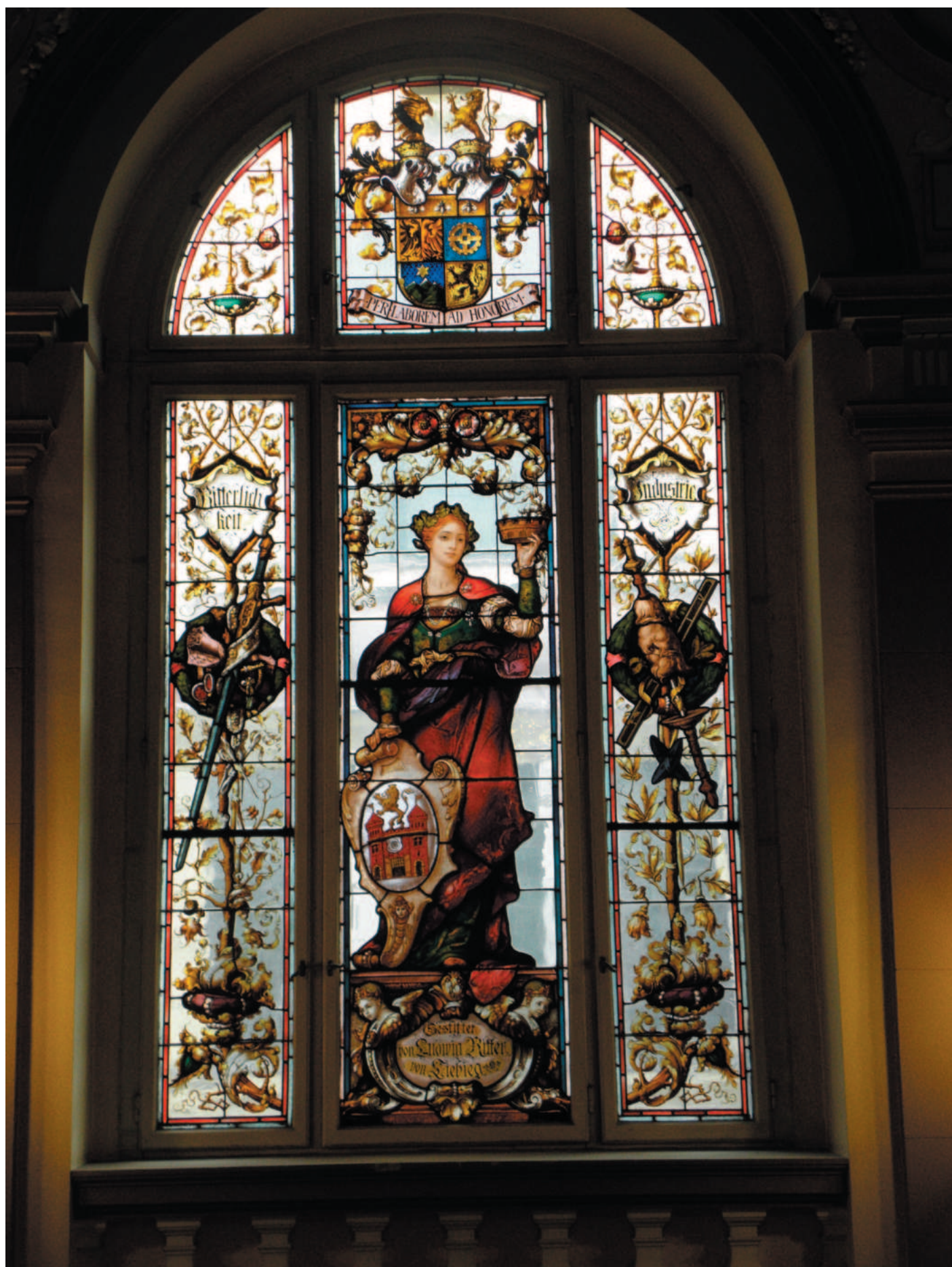
Spodní středová vitraj oken mezipatra. Je zde vidět vynikající výtvarná a řemeslná práce. Vitraj je v ploše neporušená, olověná vazba původní. Sponzoroval ji Ludwig Rittner z Liebiegu. Při přemístění vitraje do nových rámců bude vitraj přeložena do nové olověné vazby.
