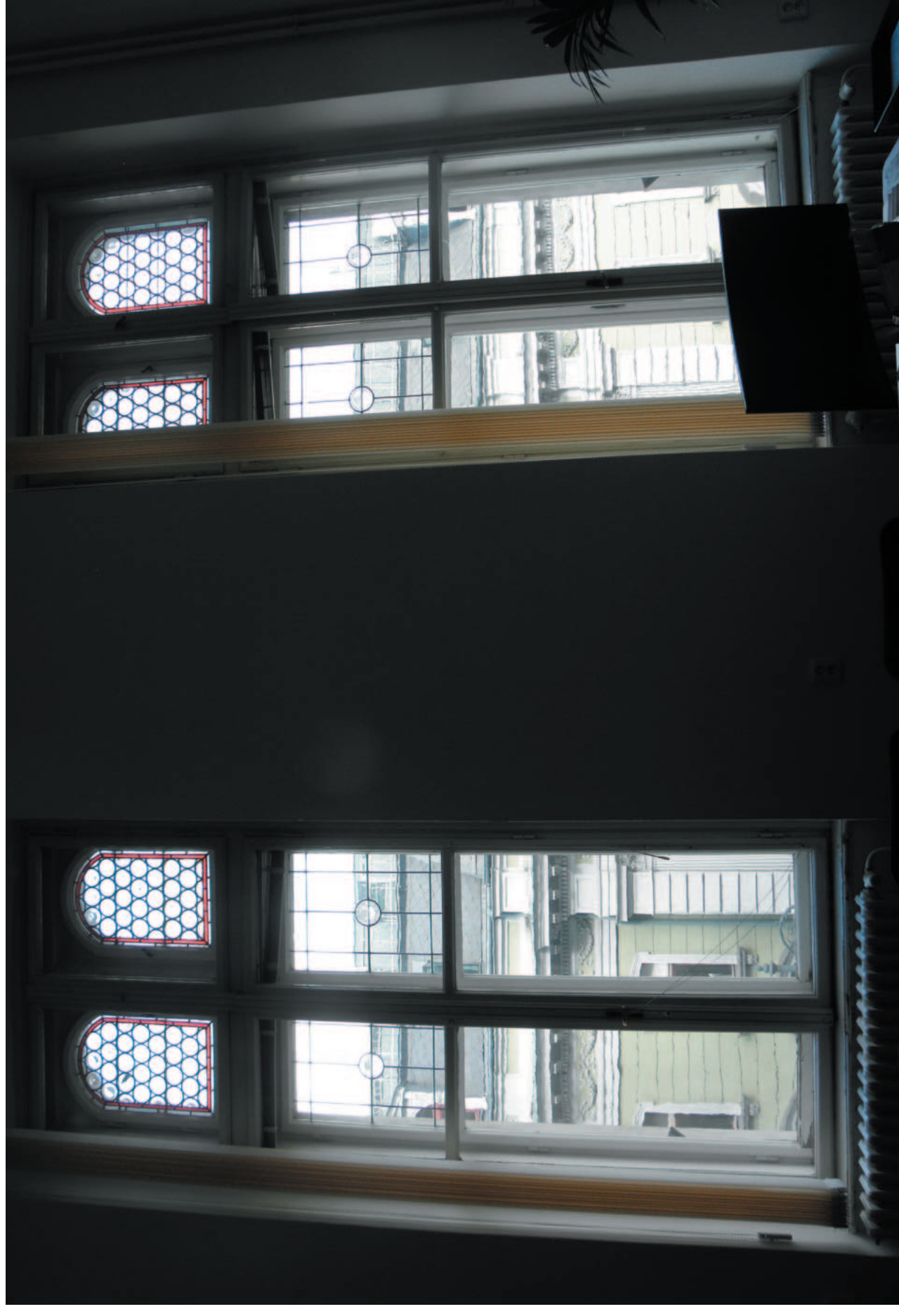
Kancelář číslo místnosti 204. Zde jsou dvě čtyřkřídlá okna v horní polovině s vitrajovými výplněmi . Výplně s bucnami mají červenou čírou borduru. Výplně bude nutné přeložit do nové olověné vazby.
