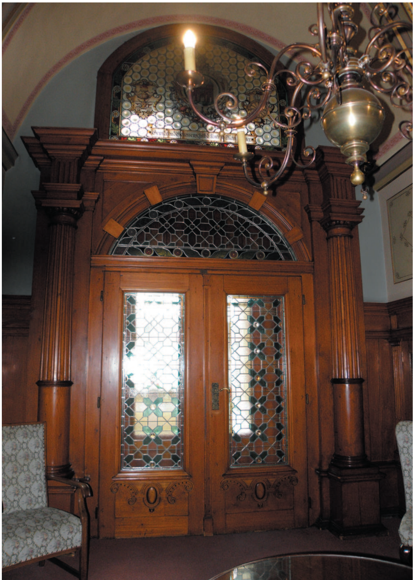
Předsálí zasedacích místností č. 209 a 210. Je zde dveřní vitraj, která byla v nedávné době zrestaurovaná. Vitraj z bucen a malovanými erby u vrcholu oblouku restaurovaná dosud nebyla a je již v ploše mírně deformovaná a tudíž v ploše uvolněná. Olověná vazba je dožilá. Vitraj bude nutné přeložit do nové olověné vazby.
