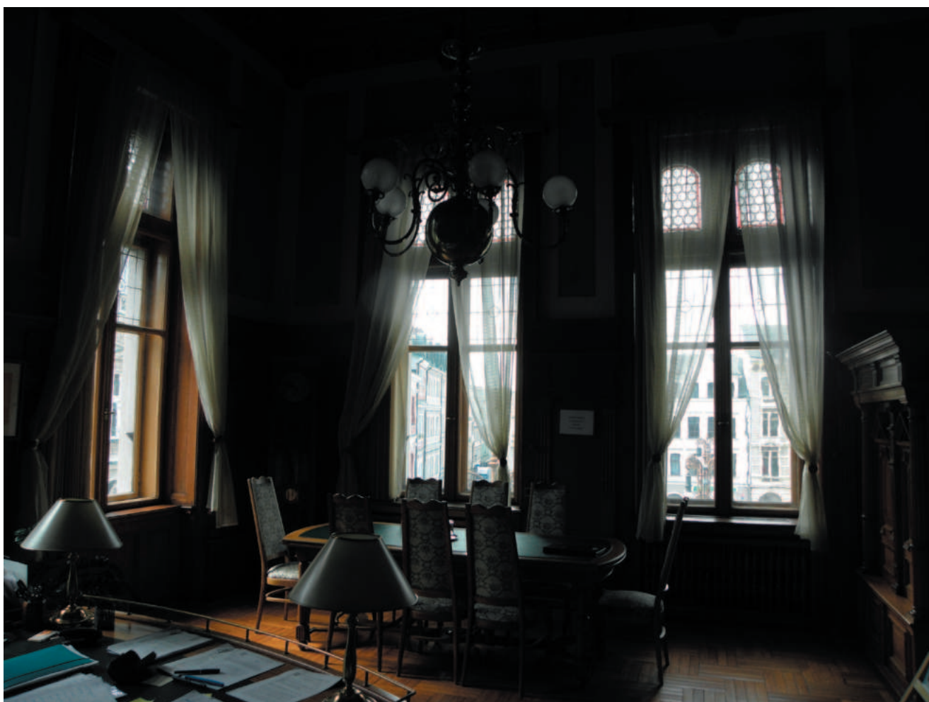
Kancelář primátora. Zde jsou čtyři stejná špaletová čtyřkřídlá okna se stejným typem vitrají v horní polovině. Výplně složené z bucen mají borduru z červeného a čirého skla.
